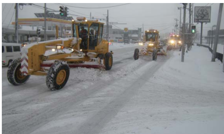
除雪グレーダによる梯団作業
