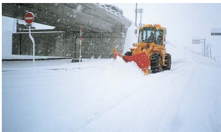
インターチェンジランプ部での作業
