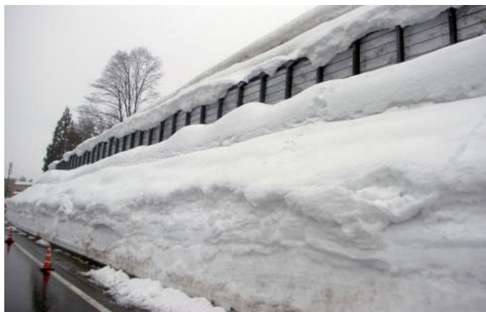
雪庇・雪堤状況
