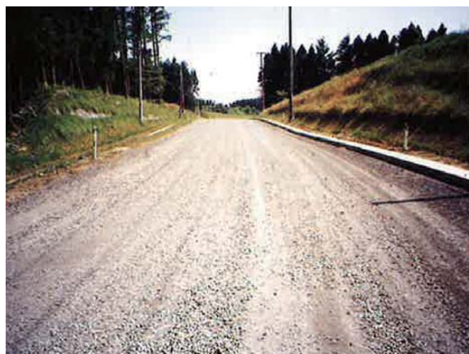
②路盤改良工事完成後
