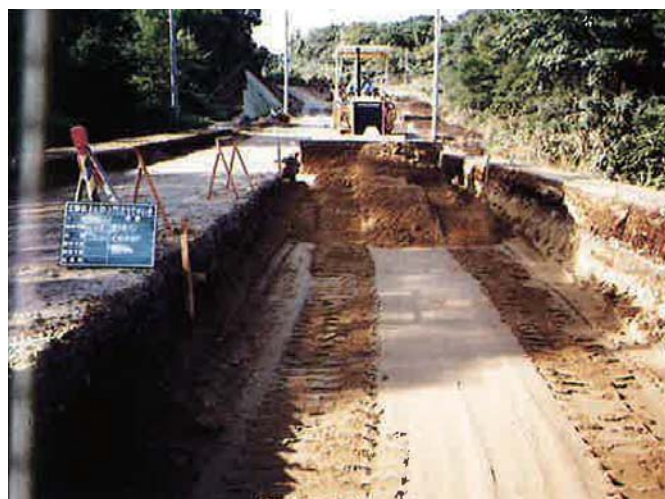
①路盤改良工事の状況
