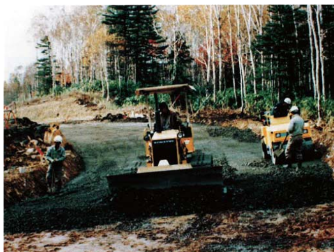
③路盤改良工事の状況
