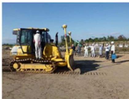
ICT-MC建機(ブルドーザ)の実践
