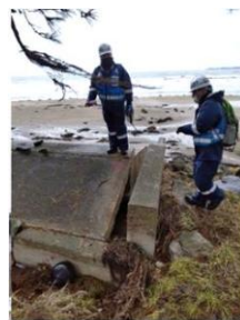
津波被災状況調査
