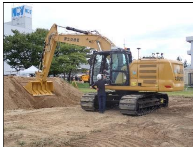
遠隔施工バックホウ操作体験
