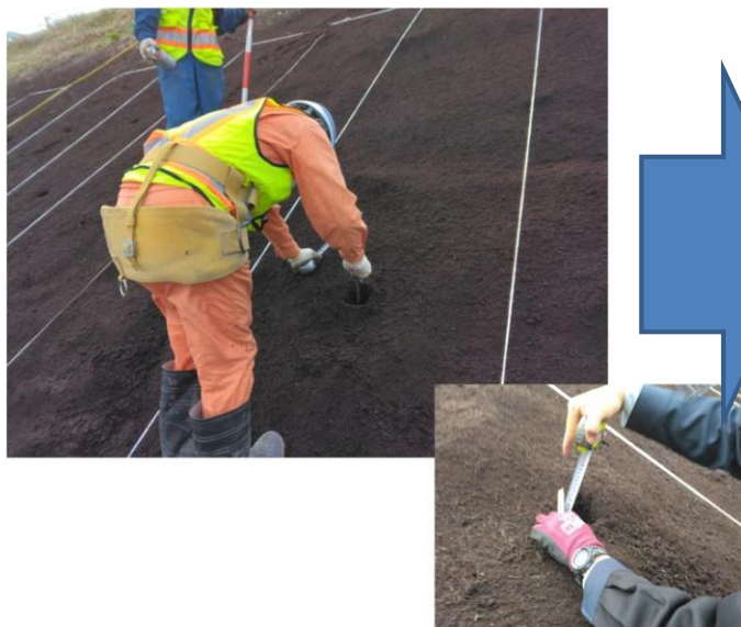
人力による出来形計測状況
