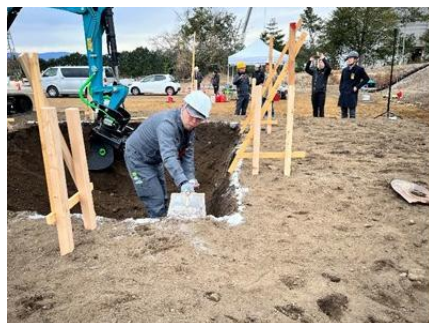
手元作業員が多い現場
