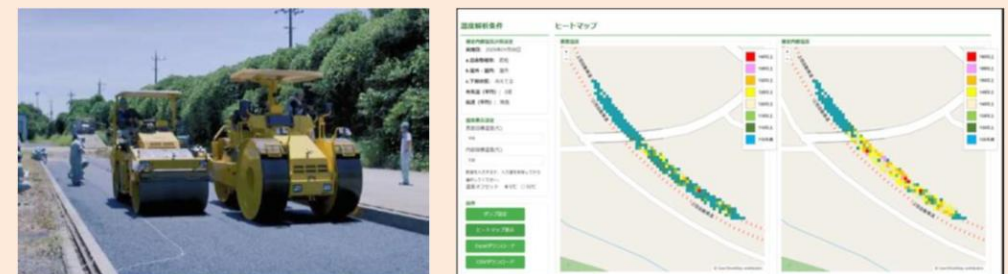
【車両等に取り付けた表面温度測定装置で計測】
