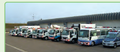
さいがいたいさくよう きがいかくのうこ 災害対策用機械格納庫
