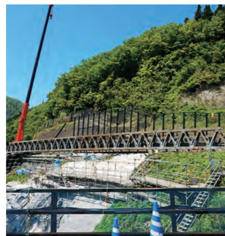
つか はし く た クレーンを使って橋を組み立てます。
