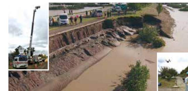
通信衛星車と無人航空機(UAV)が連携し被災状況動画を配信
