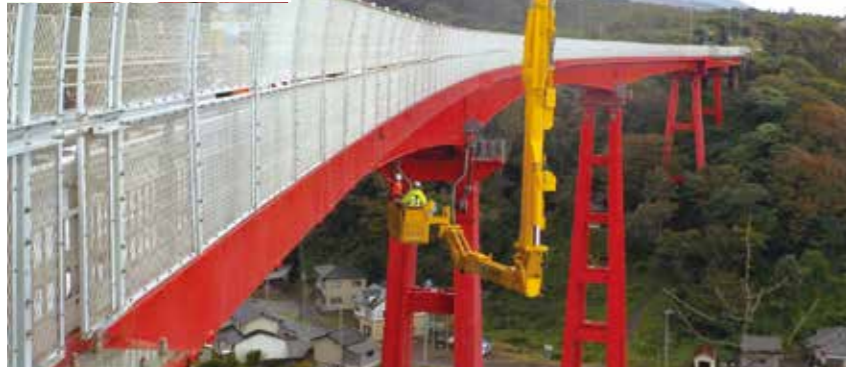
橋梁点検車を使った点検
