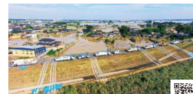
排水ポンプ車により浸水した市街地の排水作業を実施
