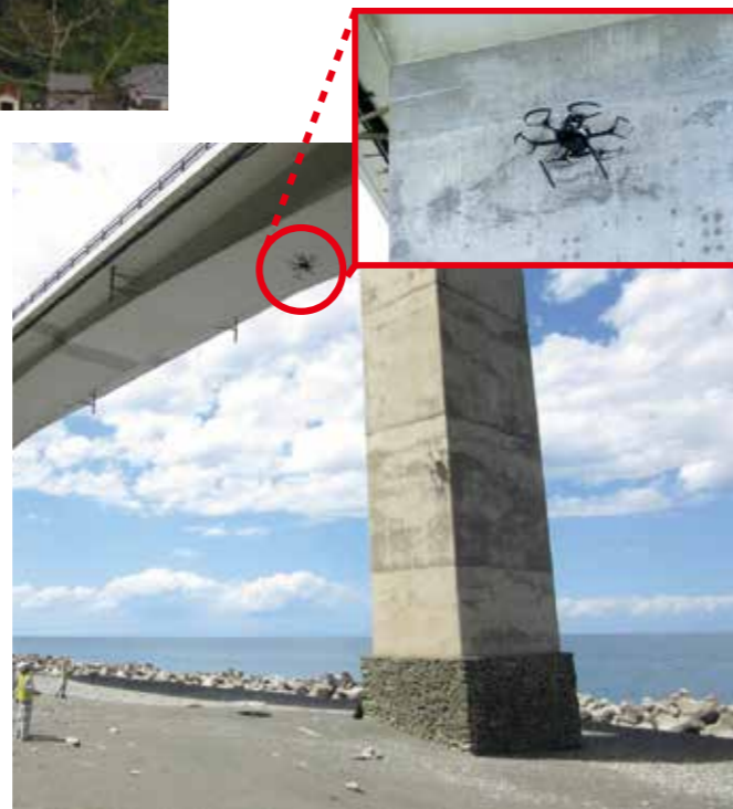
新技術を活用した点検(UAV活用の例)
