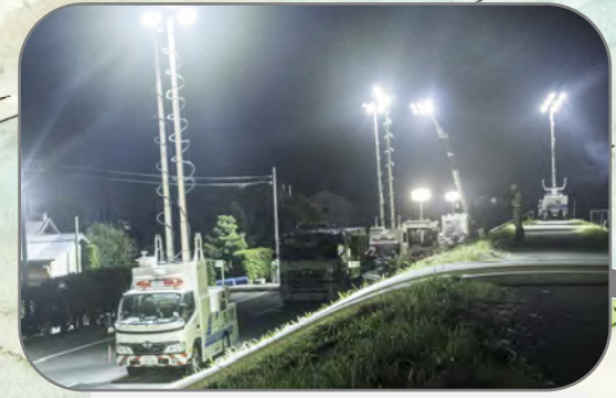
■照明車 夜間の作業復旧活動時に、作業現場を照らします。
