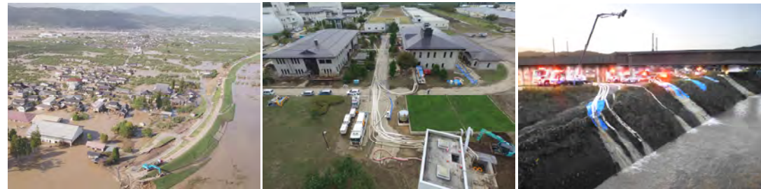
令和元年東日本台風
