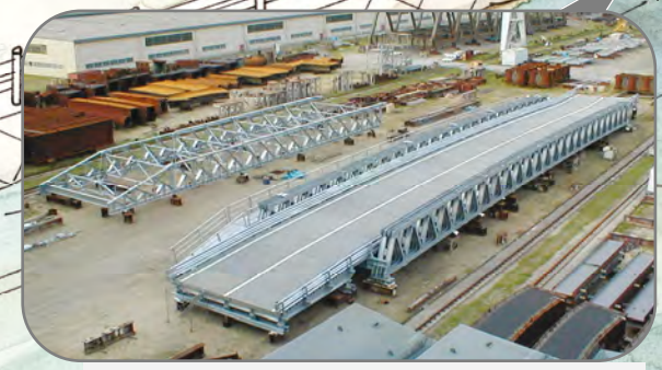
■応急組立橋 橋梁の流失・破損・道路崩壊により通行不能となった道路を緊急に確保するために使用します。
