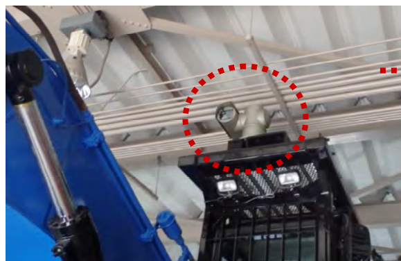
カメラ取付状況
