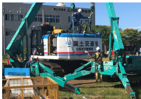
前回の分解組立訓練状況（令和4年7月）
