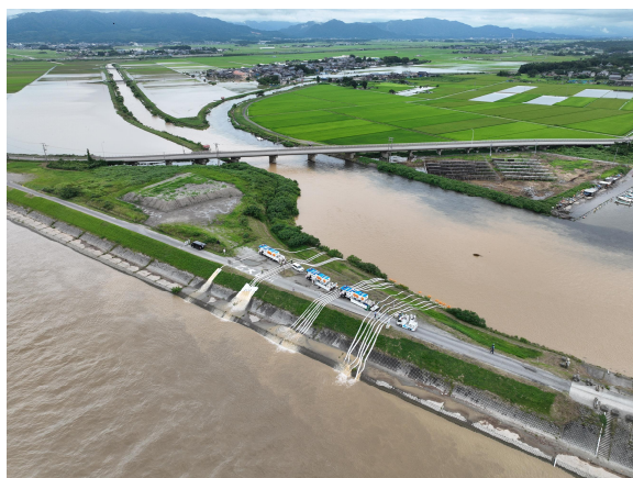
令和5年8月豪雨の排水作業（新潟県村上市乙大日川）
