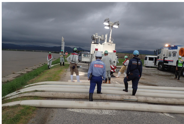
令和5年8月豪雨の排水作業（新潟県村上市乙大日川）
