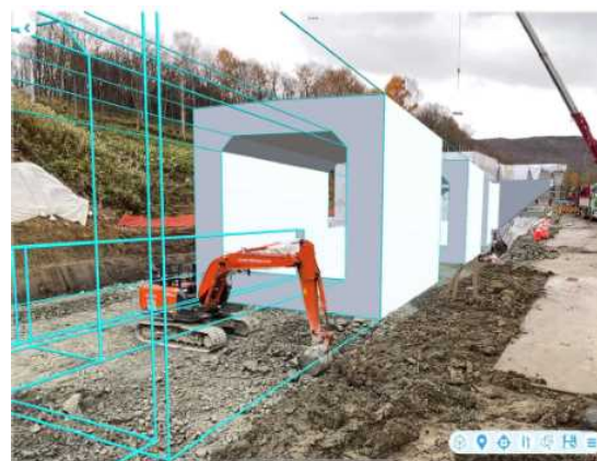
掘削作業時にARと比較した同時出来形管理
