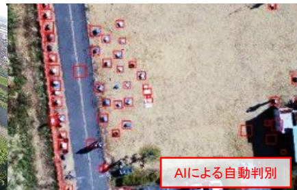
▼ドローン撮影画像からAIによる異常確認
