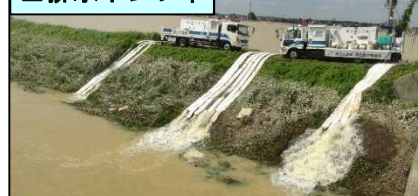
【 H27.9 関東・東北豪雨 】 (茨城県常総市)
