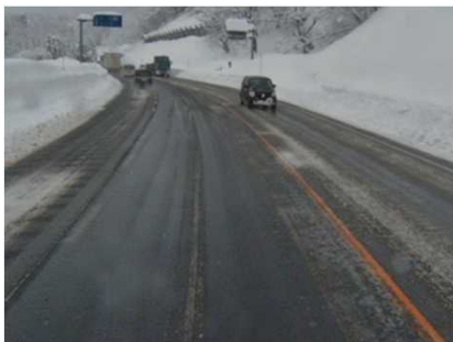
凍結抑制舗装(代表工区) (路面露出率77%)
