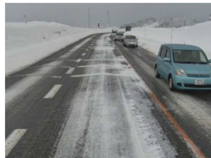
密粒度舗装(路面露出率18%)
