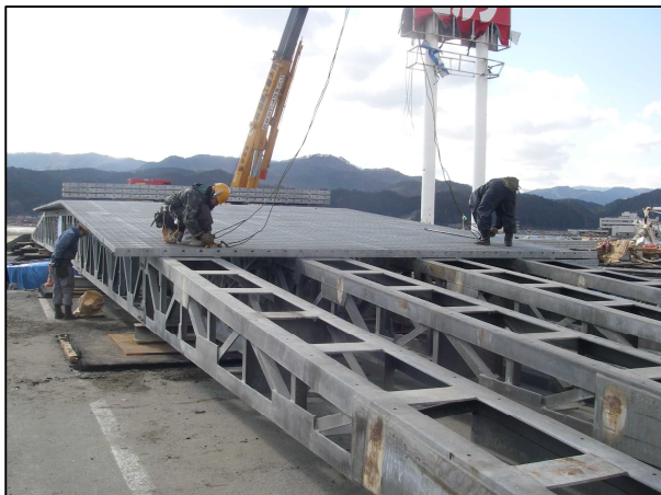
(参考) 東日本大震災時架設状況(岩手県陸前高田市)
