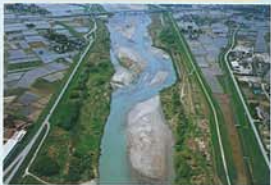
堤防 (常願寺川)
