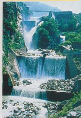
白岩砂防えん堤 (常願寺川)
