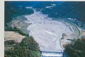
本宮砂防えん堤 (常願寺川)
