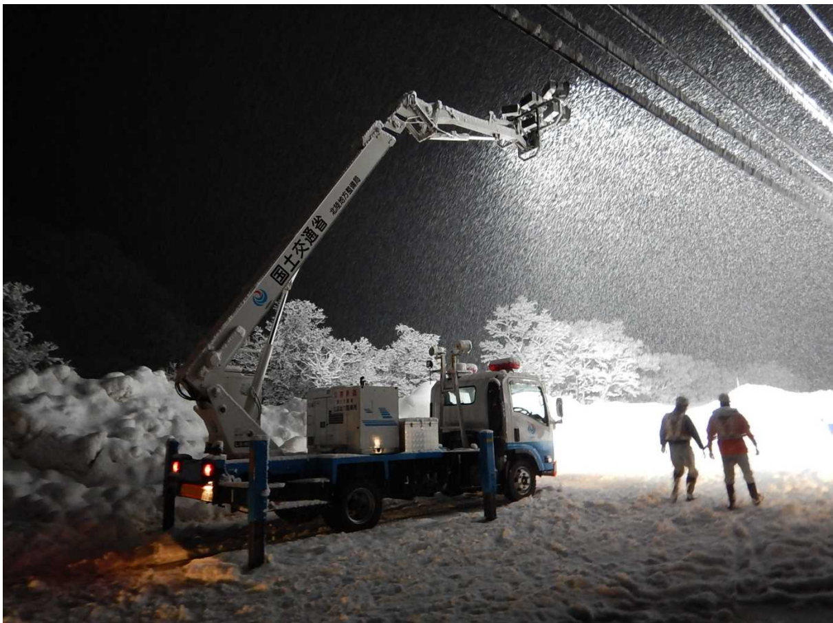
平成29年1月に発生した南砺市利賀村上百瀬中村地内地すべり災害
