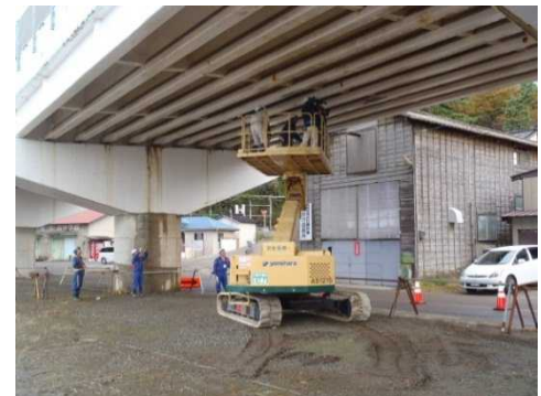
高所作業車を用いた点検(例)
