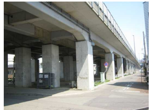
国道8号 長岡高架橋
