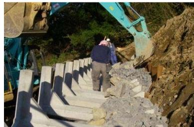
写真-4 中詰材・裏込材施工状況
