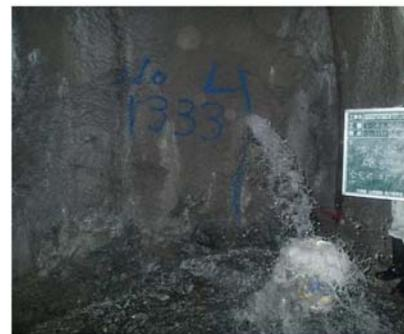
写真-2 断層部での多量湧水
