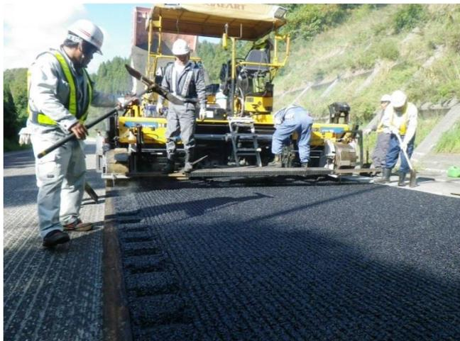
写真-1 トレッドマシーン併用時の敷均し
