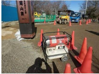
写真-2 骨材の加熱
