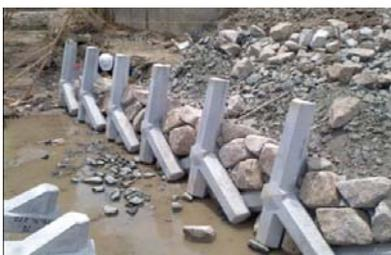
写真-3 1段目～前石設置状況
