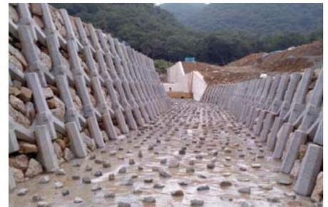
写真-16 河川護岸完成写真①
