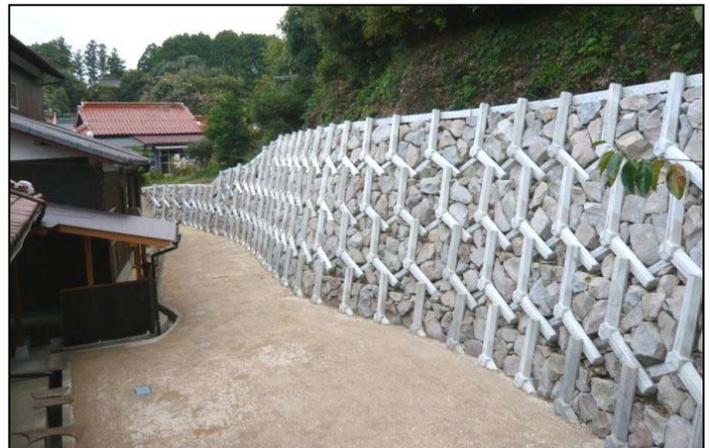
写真-9 曲線配置、高さ変化
