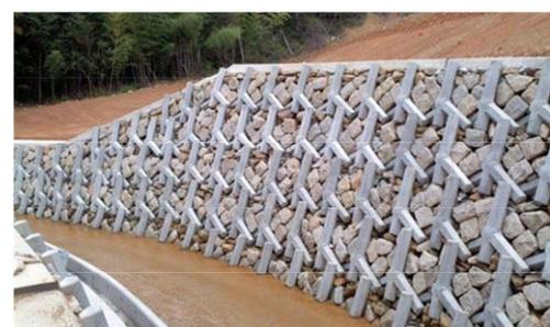
写真-10 河川右岸擁壁施工例
