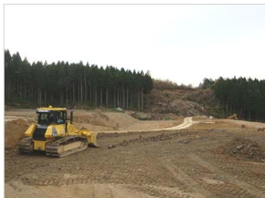
写真-4 ICT油圧ブルドーザによる盛土工
