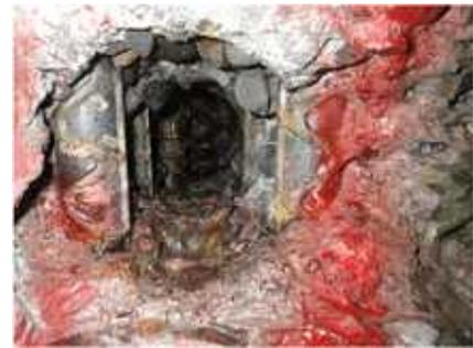
写真 - 3 既設鉄筋の支障状況
