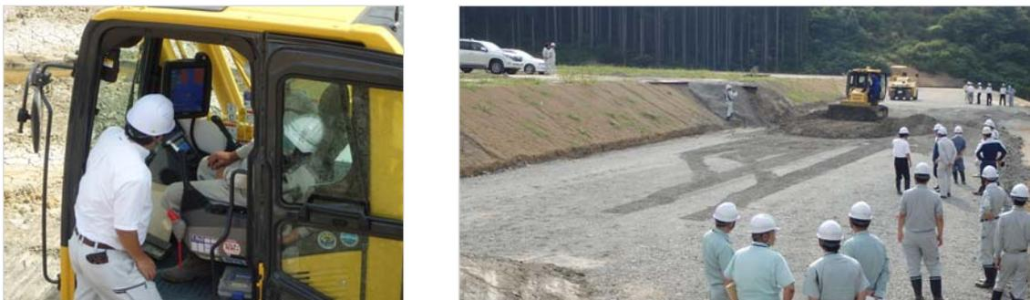
写真-9 現場でのICT建設機械の「機能説明・操作指導」
