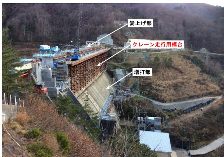
写真－3 クレーン走行用構台の設置状況
