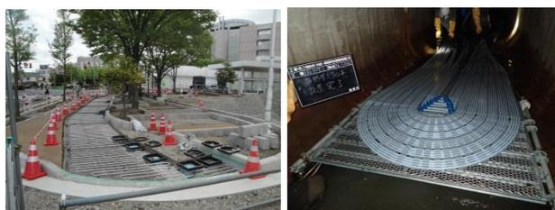
写真-1 施設写真(左：放熱パネル・右：採熱管)
