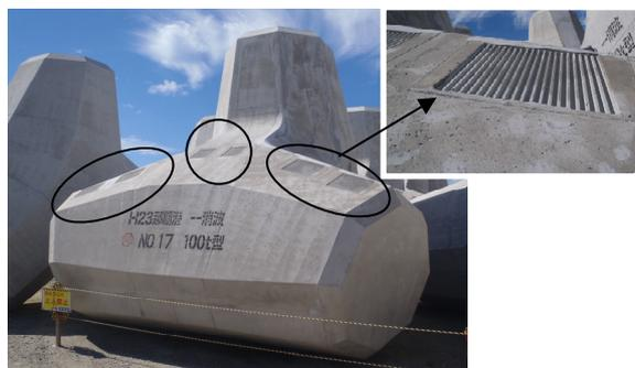
写真-6 サンゴ着生に配慮した表面加工例
