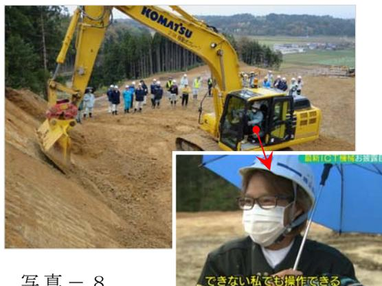
写真-8 女性オペレータによる法面整形
