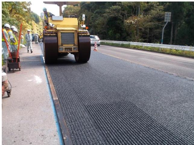
写真-2 FFP・注意喚起舗装の転圧例
