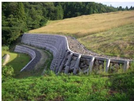
写真-14 完成全景（2段擁壁+盛土）
