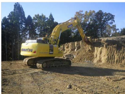
写真-3 ICT油圧ショベルによる切土工
