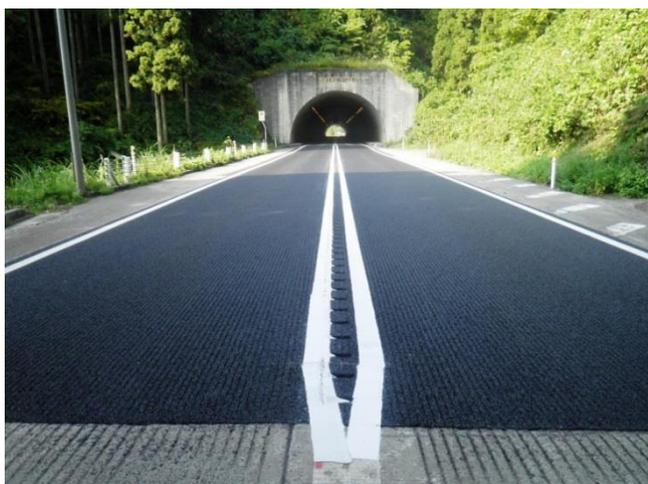
写真-3 注意喚起舗装を併設した事例
