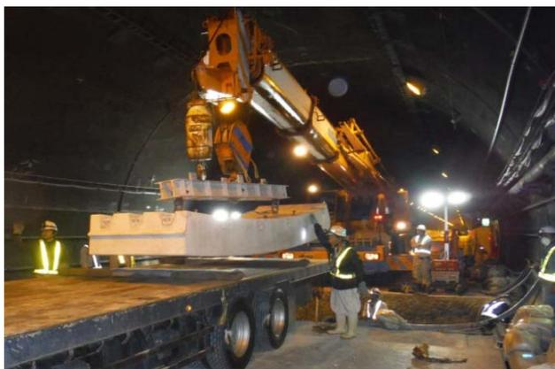
写真-4 運搬車、クレーン配置状況
