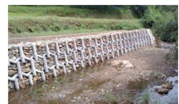
写真-6 河川護岸の施工例
