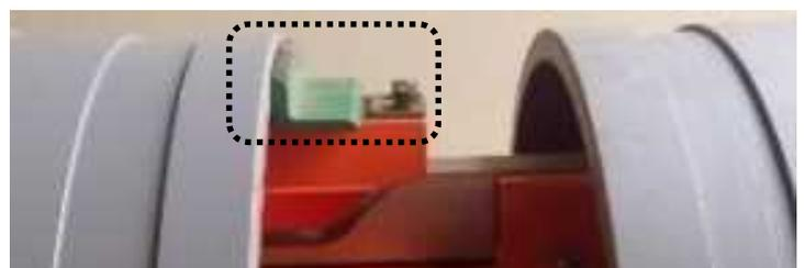
写真-2 インナー支持装置（塩ビ管設置後）
