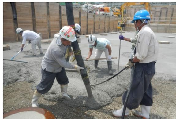
写真-1 LHCの打込み状況
