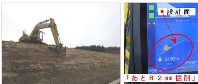
写真－2 (左)ICT油圧ショベルによる施工 (右)操作室内のモニター
