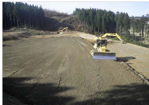
写真-7 ICT油圧ブルドーザによる盛土工
