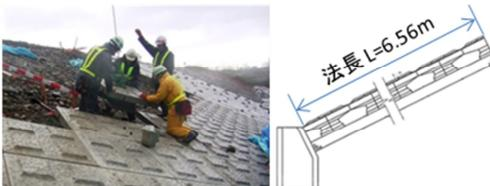
図-4 大型張りブロックのコスト比較及び施工イメージ
