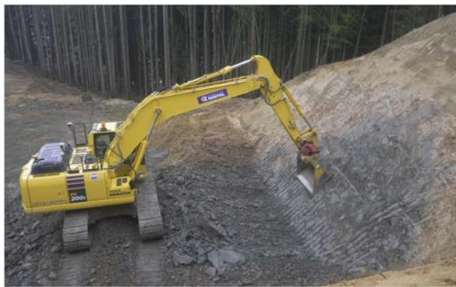
写真-5 ICT油圧ショベルによる法面整形
