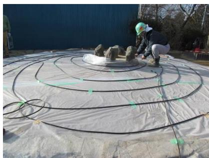
写真-7 電熱線による加熱養生
