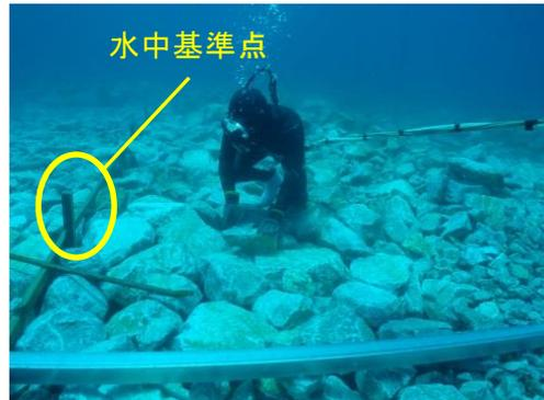
写真－1 基礎工の水中基準点
