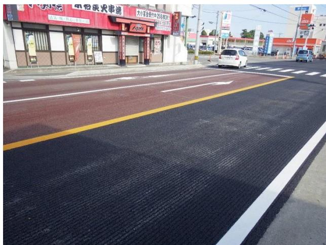
写真-4 カラー混合物を舗設した事例
