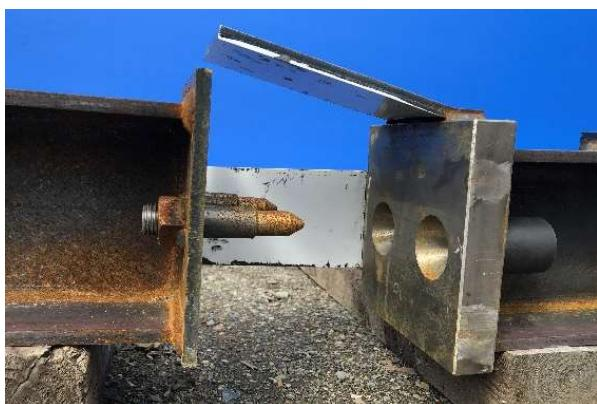
写真-6 天端継手部の工夫
