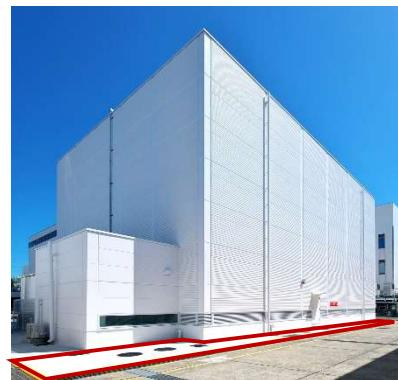
写真2 セメント・ゼロ型の現場打ちでの適用例
