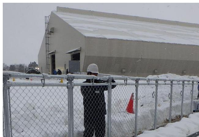
写真2.3 積雪深60cm時の屋根堆雪状況
