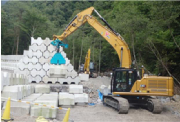
図（写真）－8 無人化 ICT 建機によるブロック据付作業の様子
