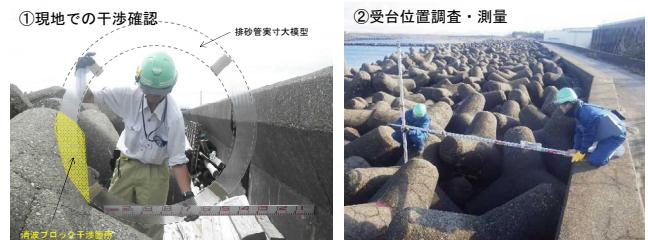
図-1 従来方法による排砂管ルート測量
