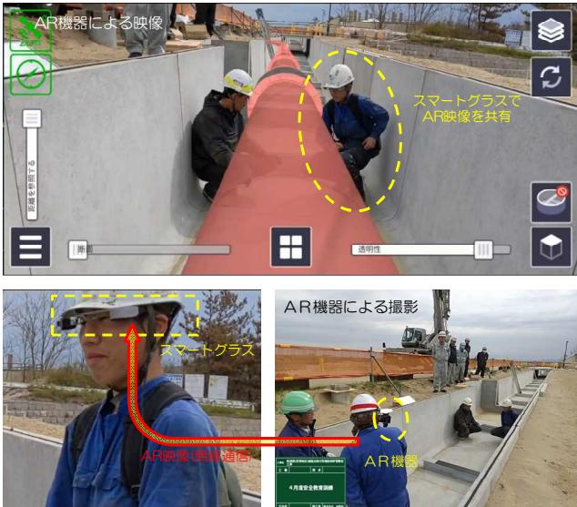
図-8 ARによる施工シミュレート
