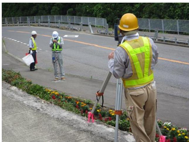
写真-2 TS による標定点設置状況
