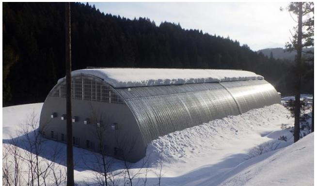
写真3. 3 積雪深60cmにおける屋根積雪状況
