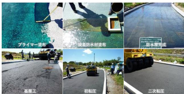
写真-4 防水層から基層までの施工状況
