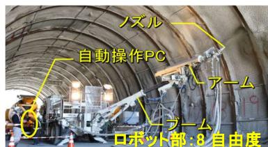
図(写真)-3 開発した自動吹付け機
