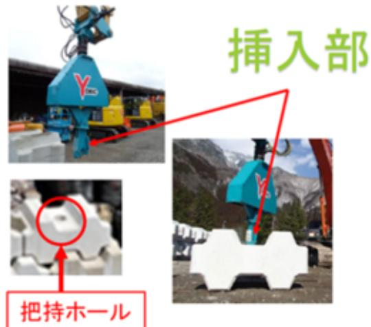
図（写真）－3 把持装置によるブロックの吊り上げ状況
