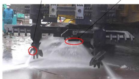
写真-4 先端吐出機構
