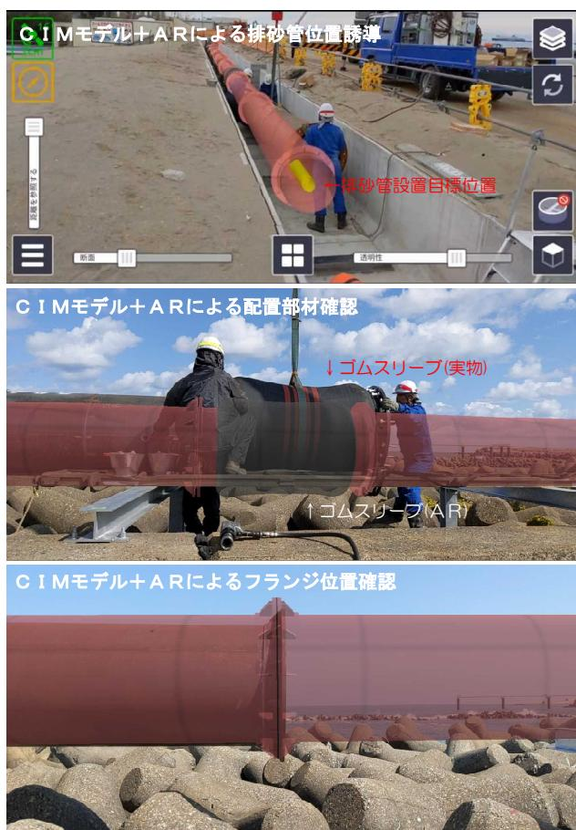
図-6 ARによる排砂管施工管理
