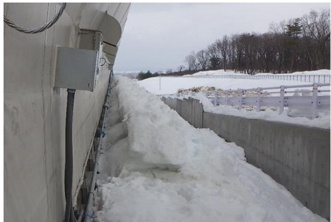
写真2.6 落雪溝融雪散水
