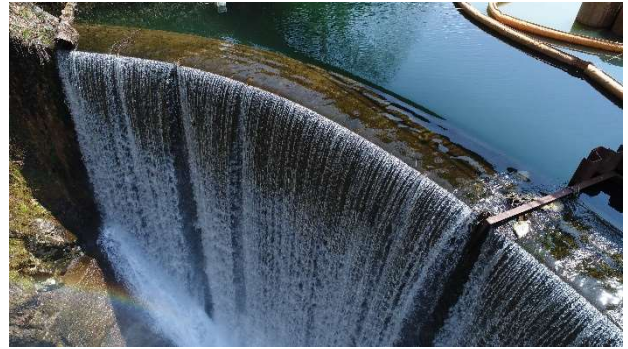
図-1 着工時の大源太第 1 号砂防堰堤
