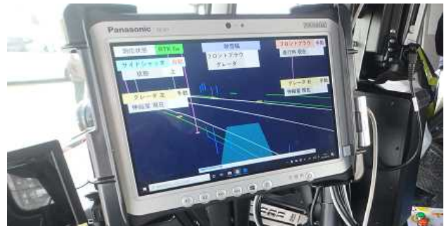
写真-2 自動操作制御装置
