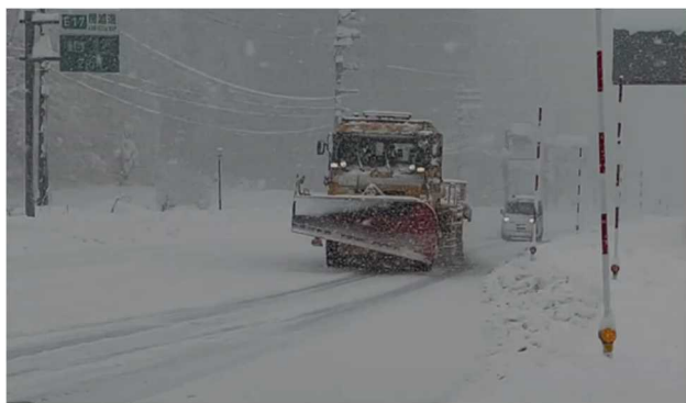
写真-4 国道 17 号での現道試験の実施状況
