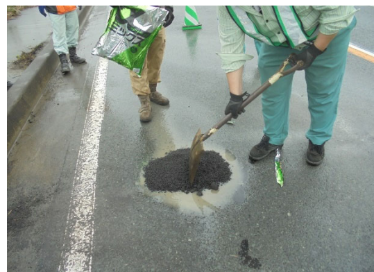
写真-4 ポットホールへの充填
