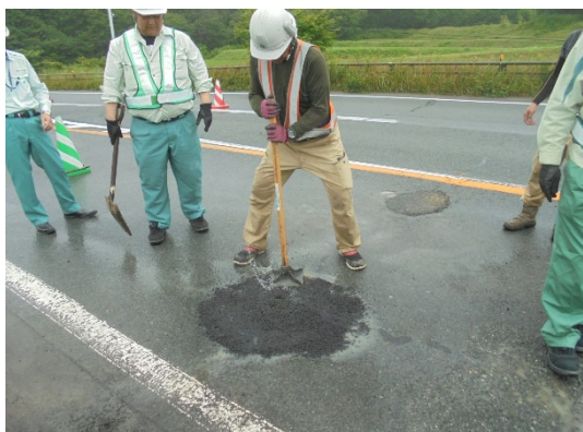
写真-6 転圧状況
