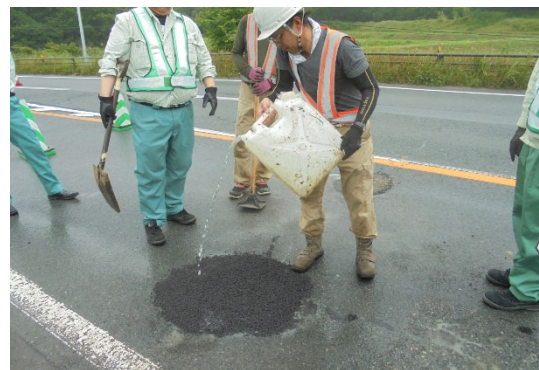
写真-5 散水状況
