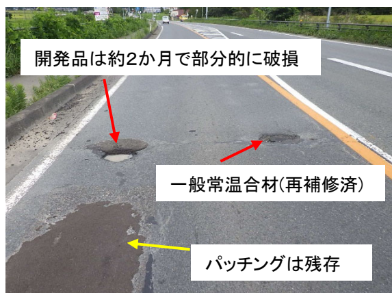
写真-8 施工2か月後の路面状況
