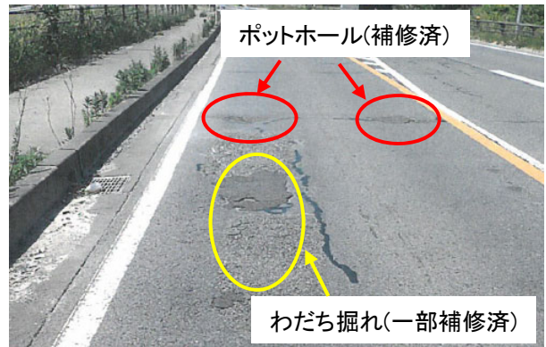
写真-2 施工前の状況
