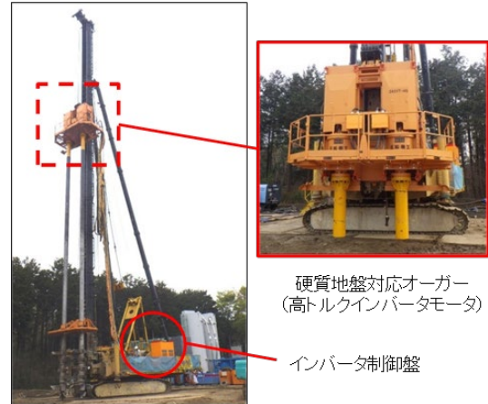
写真-2 施工機・オーガー
