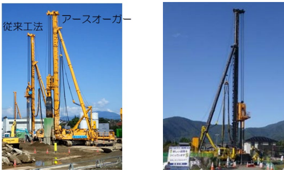
写真－5 超硬質地盤への対応 （左：従来工法 右：C I - CMC - HG工法）
