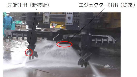
写真-4 先端吐出機構
