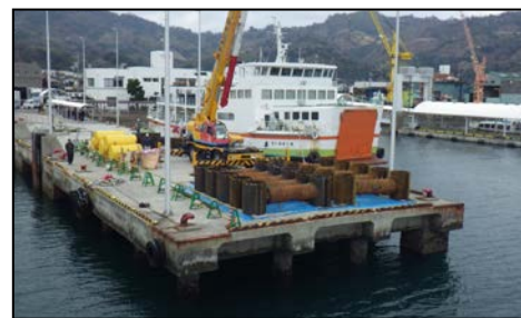
図-14 フェリー岸壁
