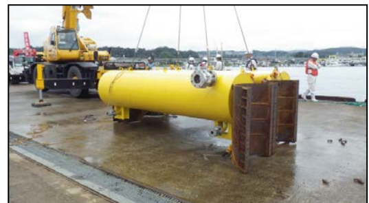
図-9 専用フロータ艀装状況
