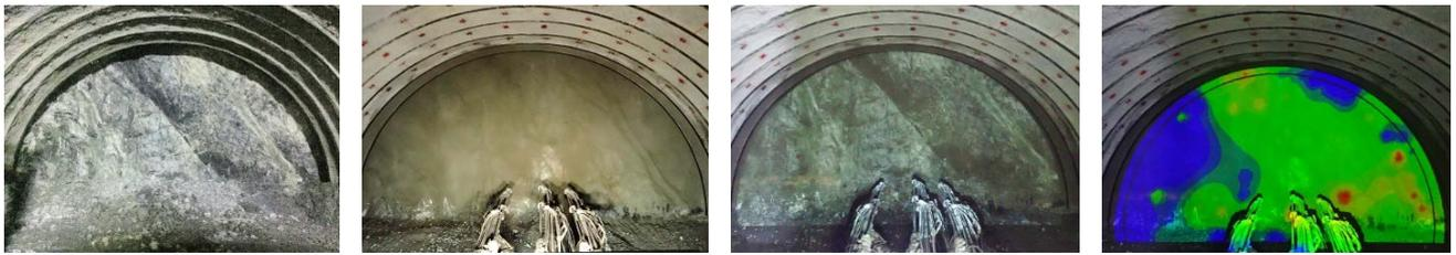
(a) 掘削直後の切羽 (b) 鏡吹き終了 (c) 切羽写真投影 (d) コンター図投影
