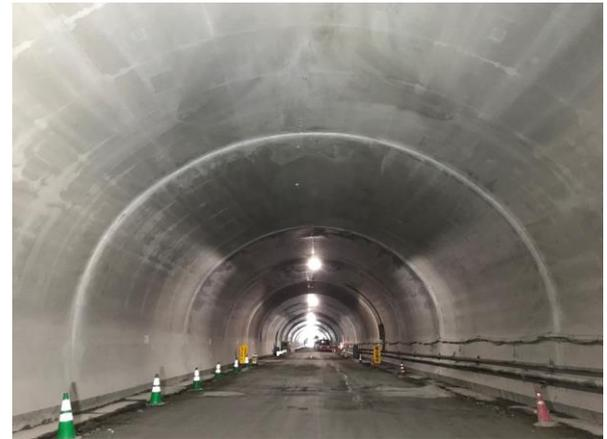
写真-6 ニューロクリート Neo で構築した覆工
