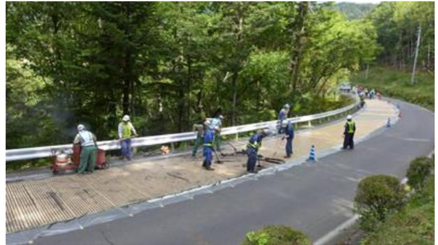
写真-1 凍結抑制材充填状況
