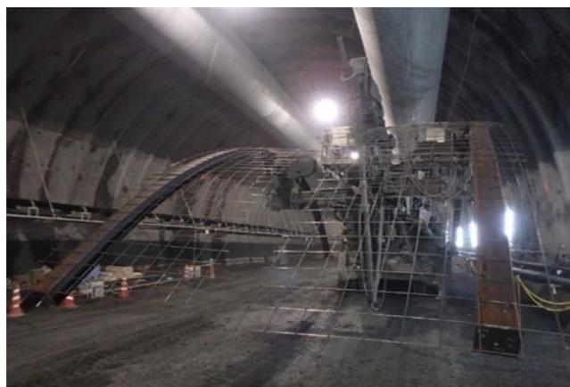
写真-6 溶接金網取付状況
