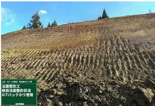
図-2 岩掘削バケットで中硬岩を整形した法面
