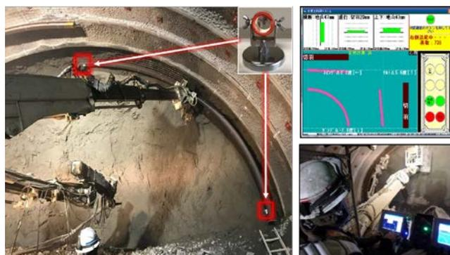
写真-7 右側鋼製支保工位置合わせ状況
