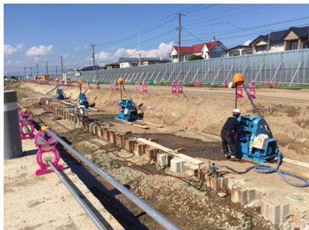
写真-4 ボーリングマシン配置状況
