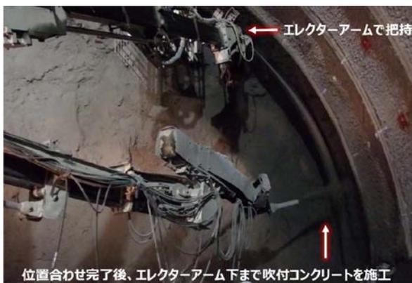
写真-8 右側鋼製支保工脚部固定状況
