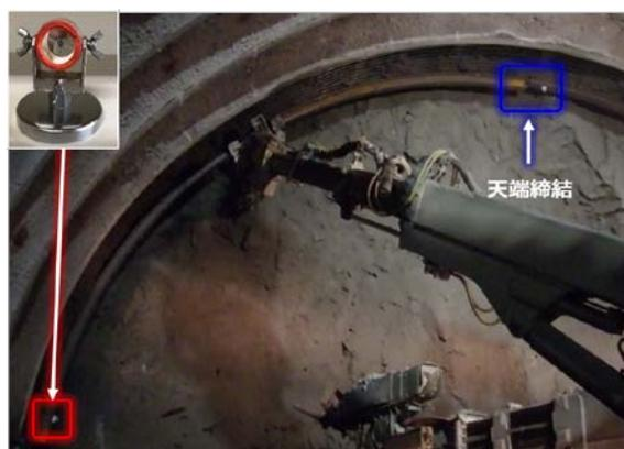
写真-9 左側鋼製支保工位置合わせ状況
