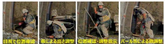
写真-3 支保工脚部の作業状況（現行）
