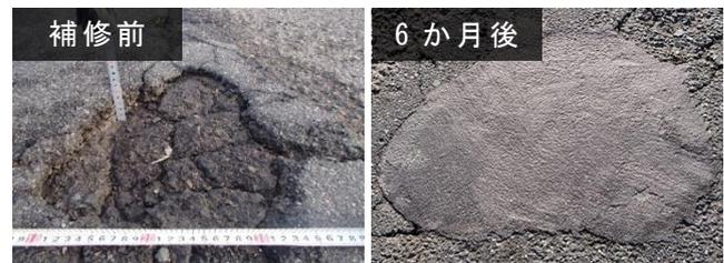
写真－7 実路での適用事例2 (穴埋め)
