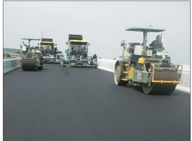
写真-4 高速道路舗装工事転圧作業状況
