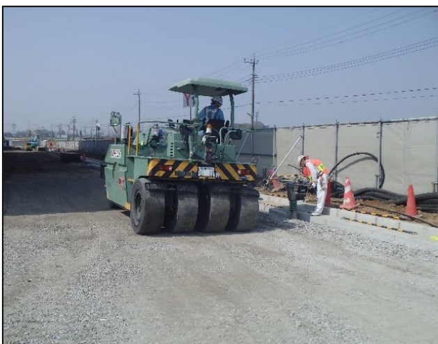
写真-3 外構工事転圧作業状況
