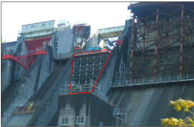
写真-1 パイプ支柱式支保工
