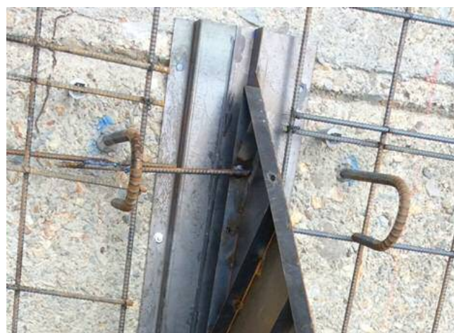
写真-4 緩衝金物と継目の接続状況
