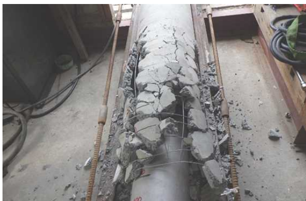
写真-2 破碎羽による破碎状況
