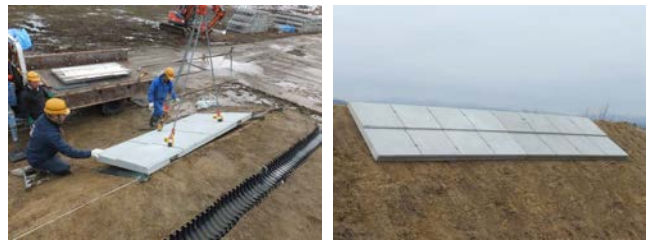
写真-4 施工性の確認と施工完了
