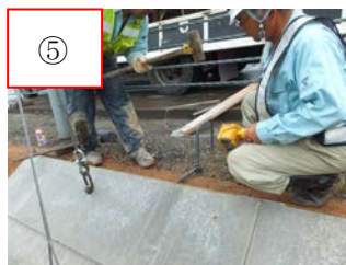
写真-10 天端アンカー鉄筋打込み
