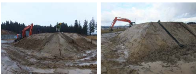
写真-3 盛土造成状況
