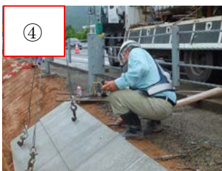
写真-9 天端アンカー鉄筋固定冶具取付
