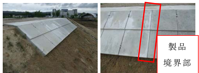
写真-5 防草効果の確認（施工後4ヶ月）
