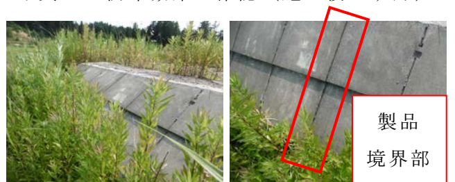
写真-6 防草効果の確認（施工後3年半）
