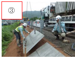
写真-8 製品施工
