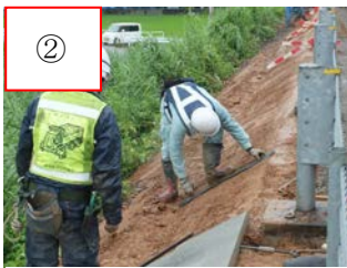
写真-7 防草シート張り付け
