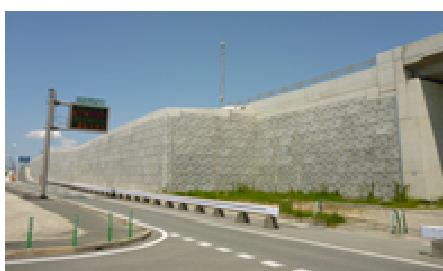
写真-1 補強土壁の外観
