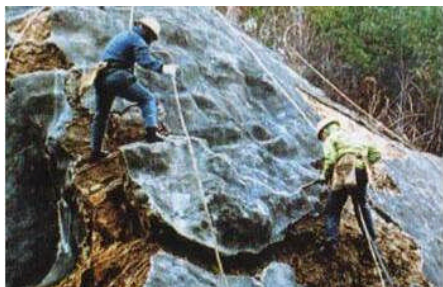
写真-2 吹付材のはつり取り状況（例）
