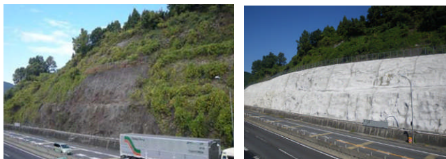
写真-4 着手前および施工後
