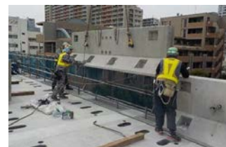
写真-6 EMC 壁高欄の設置状況
