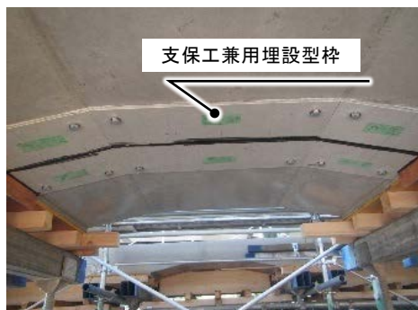
写真-5 支保工兼用埋設型枠
