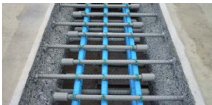
写真-4 鉄筋機械式定着継手
