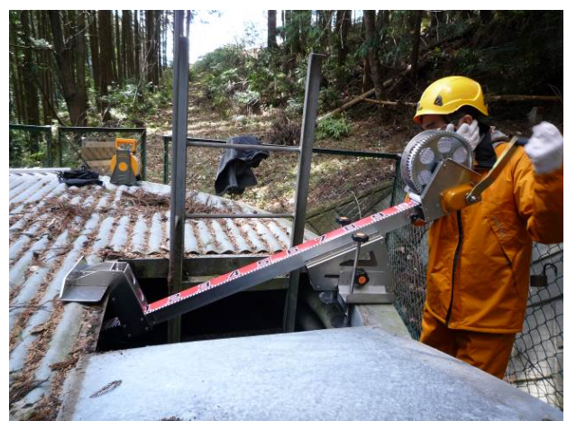
図-5 集水井内観察カメラ設置状況
