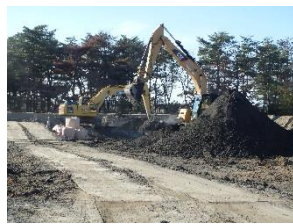
写真－５ 改良状況
