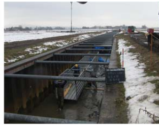
図-8 鋼製組立式仮設水路の設置状況
