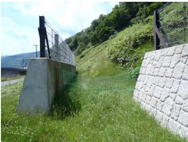
写真-3 既設擁壁の背面
