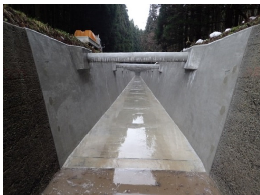
写真-2 竣工写真
