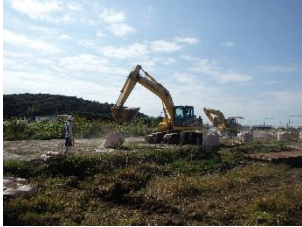
写真－２ 敷き均し
