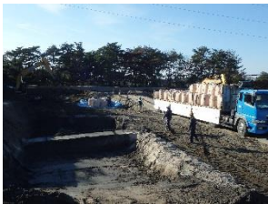
写真－４ 改良エリア
