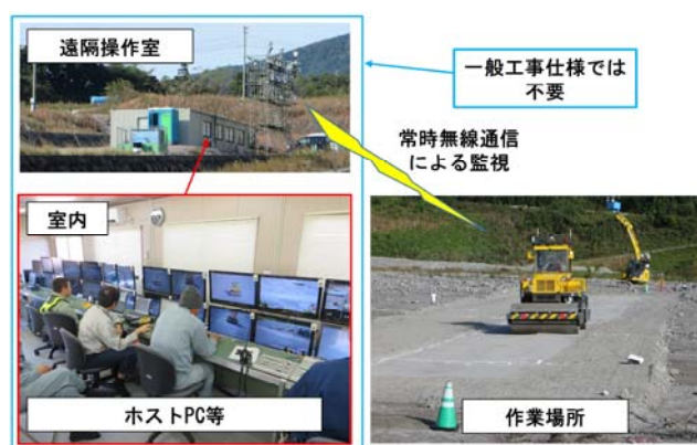
図-8 無人化施工仕様の全体システム
