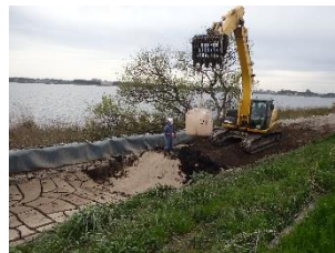
写真－８ 浚渫土改質
