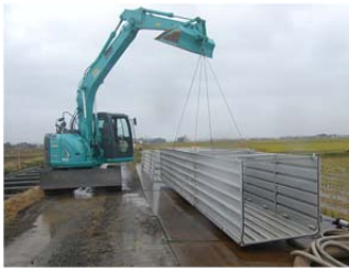
図-8 鋼製組立式仮設水路の設置状況
