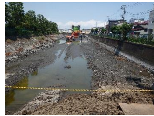
写真－６ 現場全景
