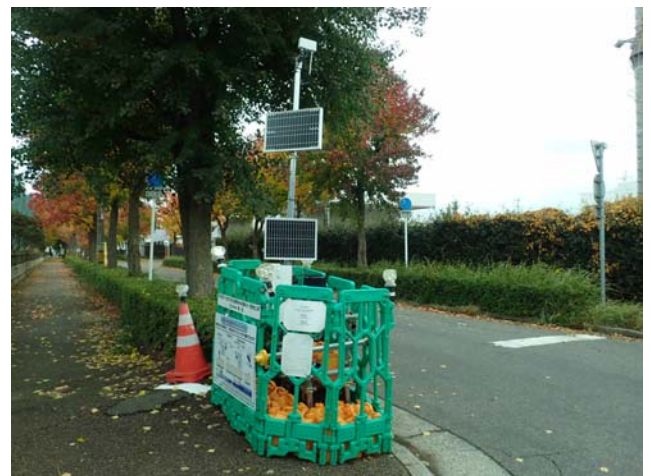
写真－３ 発信部設置状況写真
