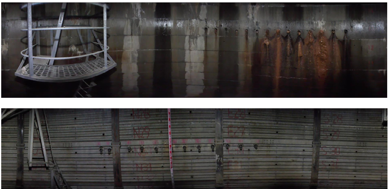
図-6 集水井内部展開写真（上図：猿供養寺地すべり，下図：譲原地すべり）
