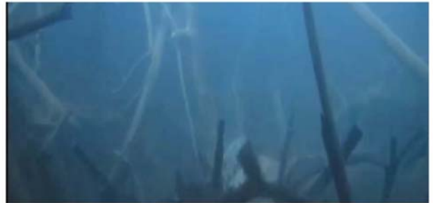
図-12 流木堆積状況 (弥栄ダム)
