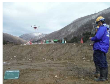
写真-6 UAVによる出来形測定
