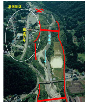
写真-1 三俣溪流保全工の整備範囲
