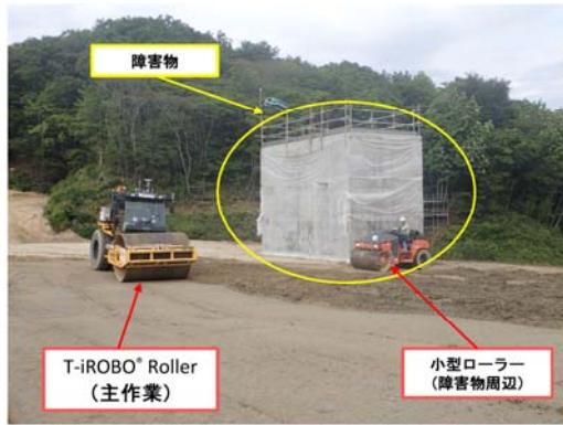
図-13 T-iROBO Rollerによる施工状況
