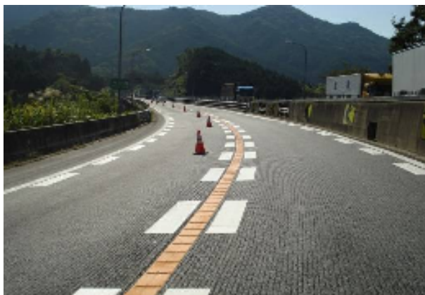
写真-5 米谷カーブ FFP 施工後の路面状況
