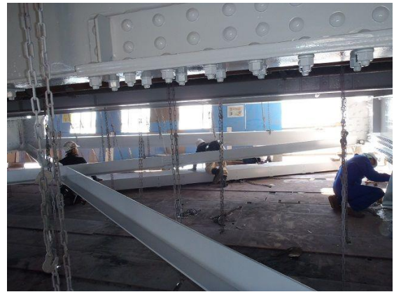
写真－10 桁下の足場への取込み
