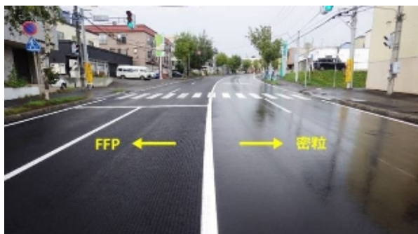
写真-3 浮き水抑制路面状況
