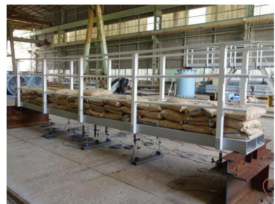
写真－2 歩廊静的載荷試験（鉛直）
