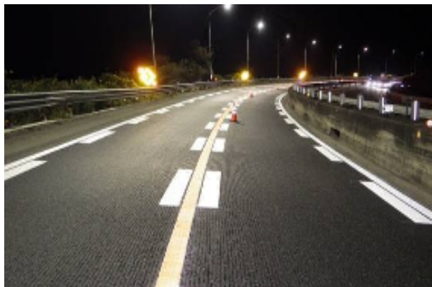
写真-6 大道カーブ FFP 施工後の路面状況
