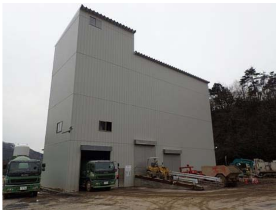
写真－５ 大容量バッチャープラント
