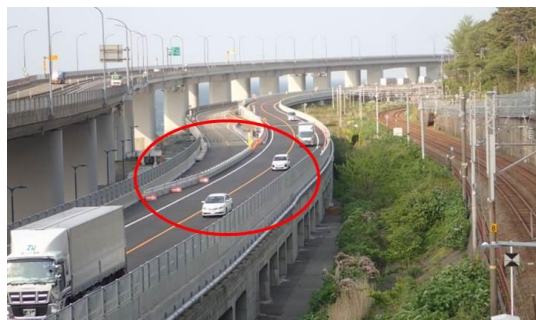
写真-10 歌高架橋新設橋への交通切り替え
