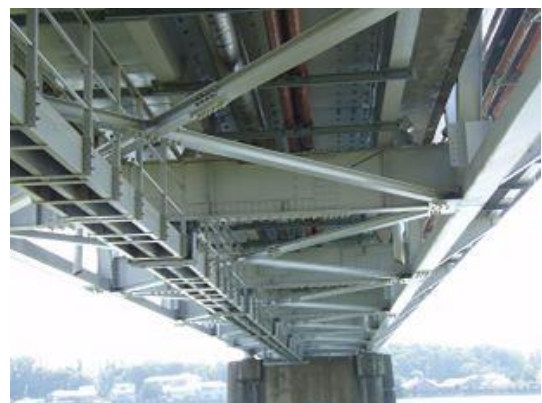
写真－12 設置完了（床版下面より）
