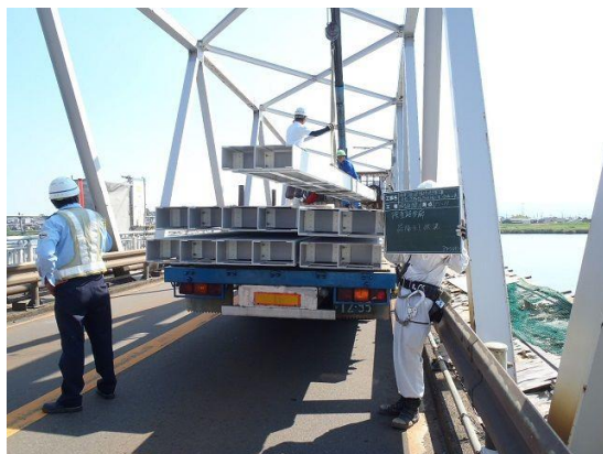
写真－8 検査路の荷卸し状況
