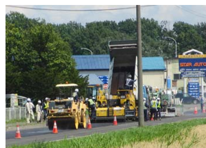
写真-3 施工状況
