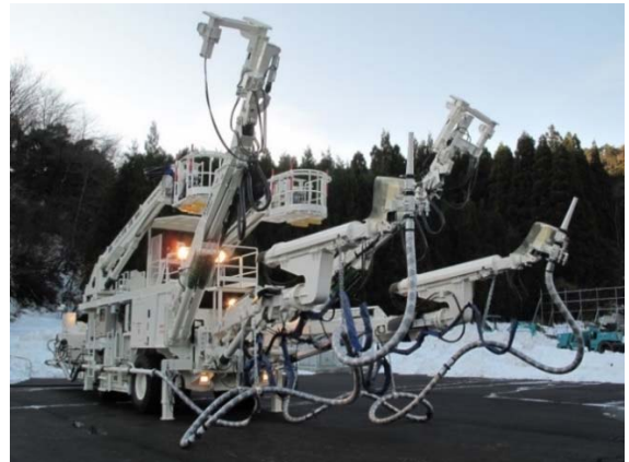
写真－６ エレクタ付２ノズル吹付け機
