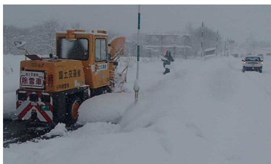
写真-4 歩道除雪作業状況
