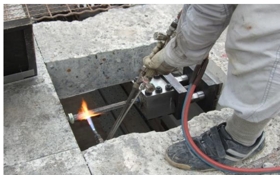
写真-9 PC鋼材の切断
