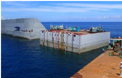
写真－3 無人化施工によるケーソン据付
