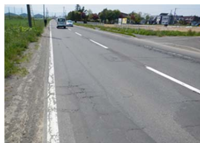
写真-2 施工前の現況
