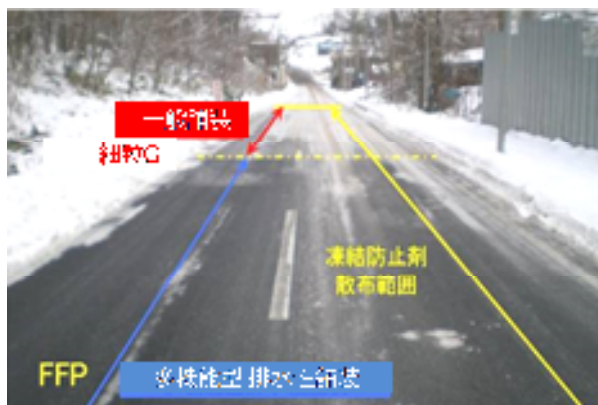
写真-1 散布後 40 時間経過後の路面状況 (札幌)
