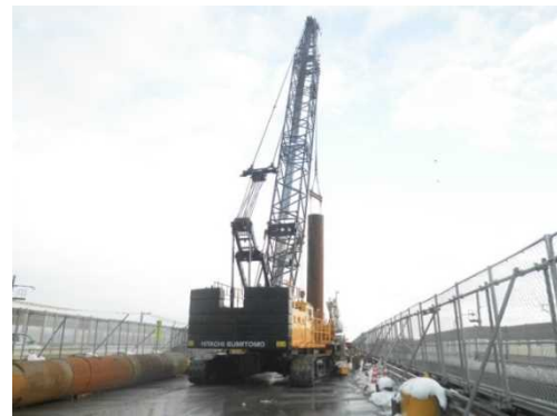
図－８ 回転貫入状況
