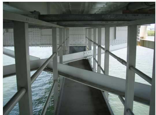
写真－11 手摺設置完了
