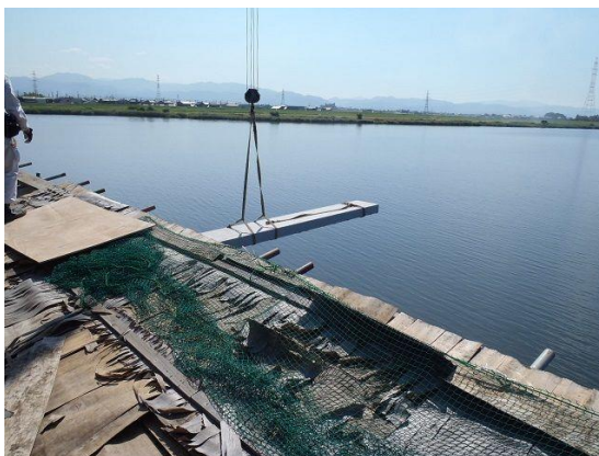
写真－9 桁下の足場への取込み
