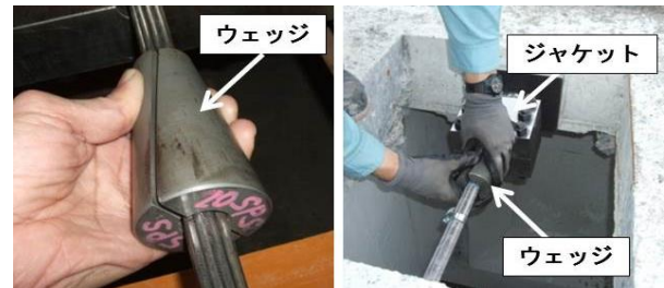
写真-5 ウェッジの装着・ジャケットとウェッジの一体化
