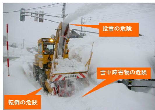
写真-1 歩道除雪作業状況
