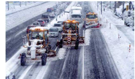
梯団除雪による迅速な除雪作業 (新潟バイパス)
