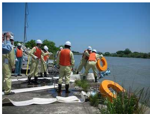
水中ポンプの投入
