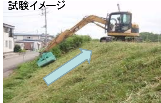
マシンコントロール機能を用いアームの作業角度を固定
