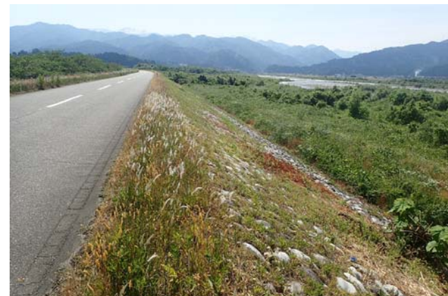
石張護岸の状況
