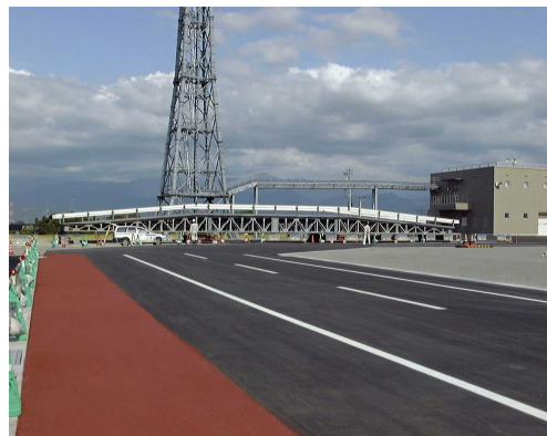
応急組立橋 側面
