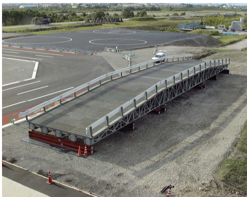
応急組立橋 全景
