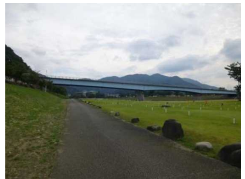
舟戸橋の全景
