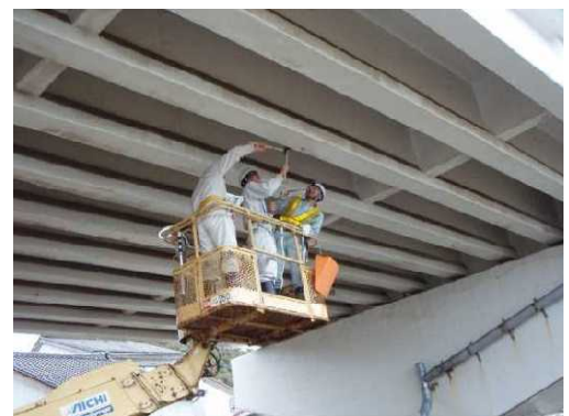
高所作業車を用いた点検
