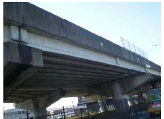
国道8号 中島高架橋
