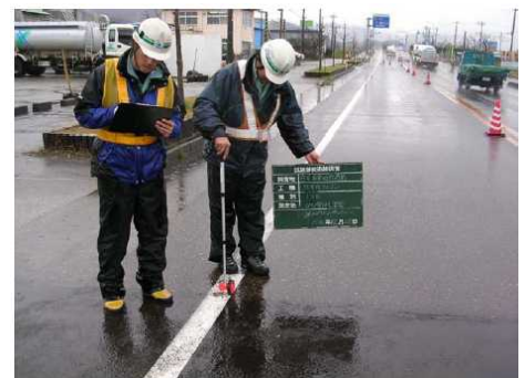
ひび割れ率調査(イメージ)
