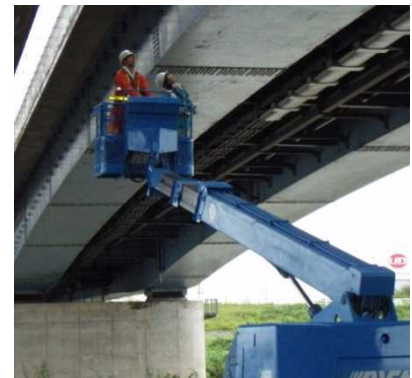
高所作業車を用いた点検
