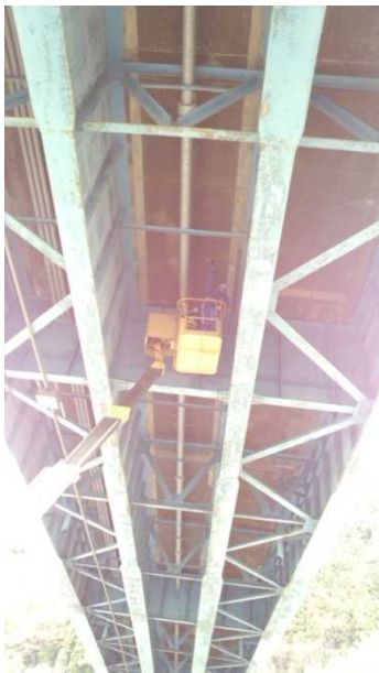
高所作業車を用いた打音調査
