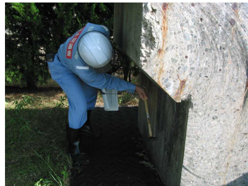
点検ハンマーを用いた打音検査の講習
