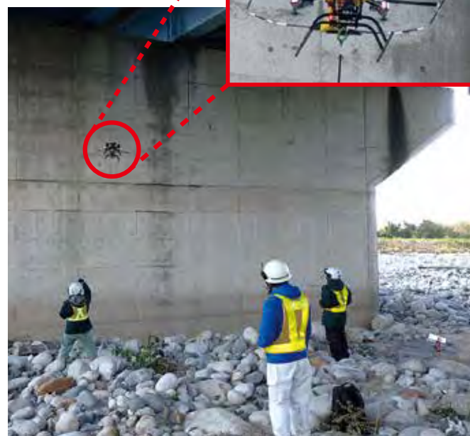
新技術を活用した橋梁点検（UAV活用の例）
