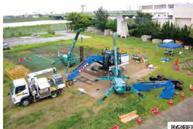
分解組立型遠隔操縦式バックホウを災害現場に速やかに 出動させるために必要な分解・組立作業の訓練を実施
