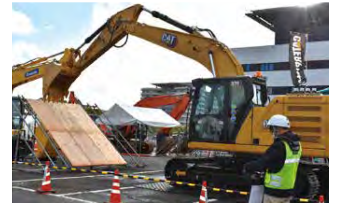
けんせつフェア北陸in新潟2021（仮想法面を用いたMCバックホウ実演）
