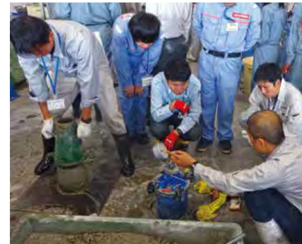
生コンクリートの品質を確認する方法を学ぶ
