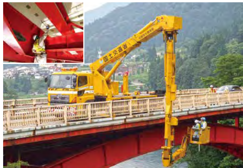
橋梁点検車を使った近接目視による点検（左上はハンマーによる打音点検）
