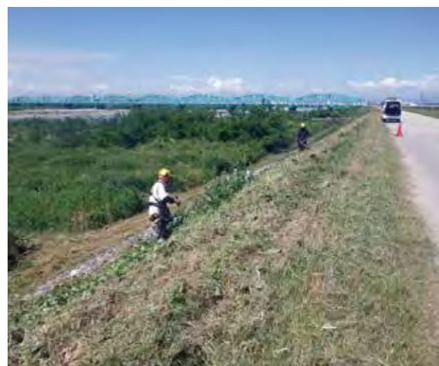
急斜面や石張護岸では、自走式除草機械が横転するため、人力による除草を実施
