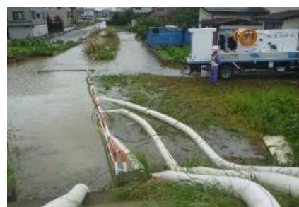
内水排除作業状況
