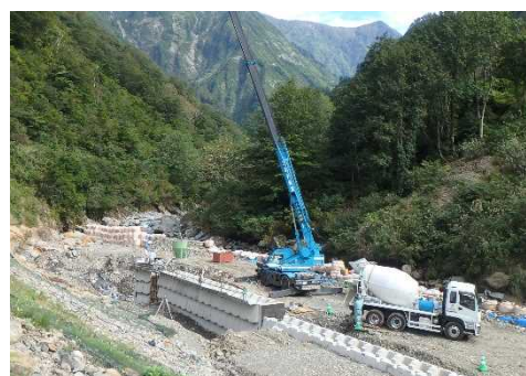
【現場施工状況】
