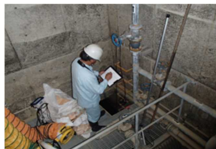
有毒ガス測定状況
