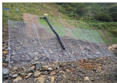
【仮設落石防護工の施工】
