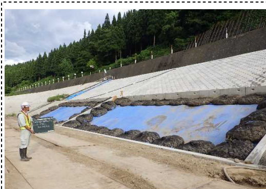
洗堀防止対策状況(出水時対策)
