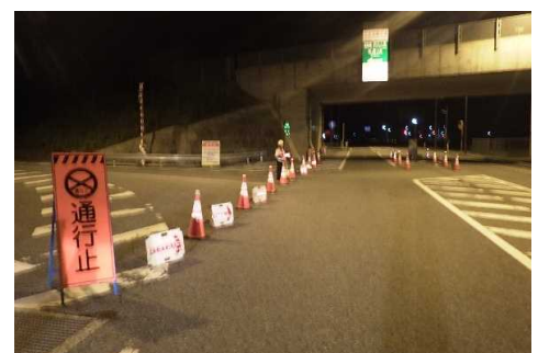
夜間でも視認性の高い規制状況
