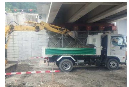
橋桁下での施工
