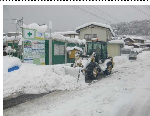
市道運搬経路除雪状況
