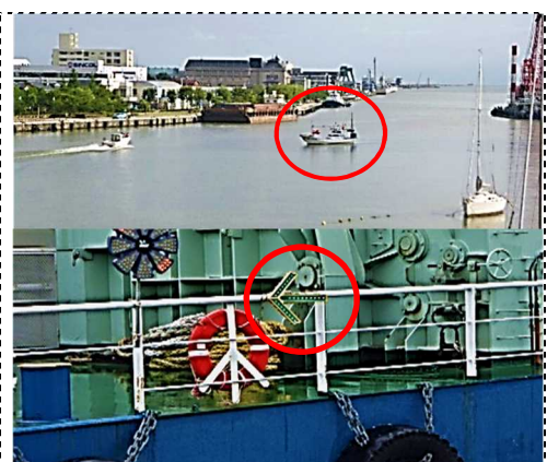
安全監視船の配置状況 グラブ船船尾にLED矢印板を設置
