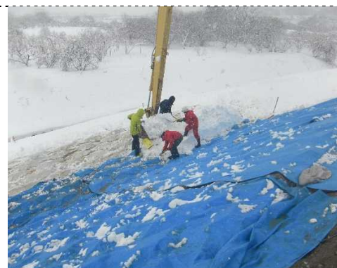
築堤法面除雪状況
