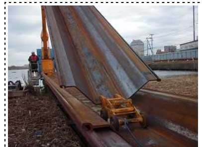
パイルローラー使用
