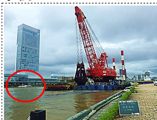
浚渫作業中の水上バス運行状況
