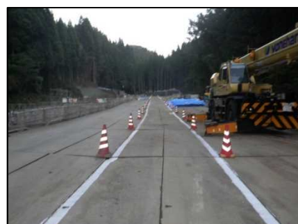
工事用道路写真
