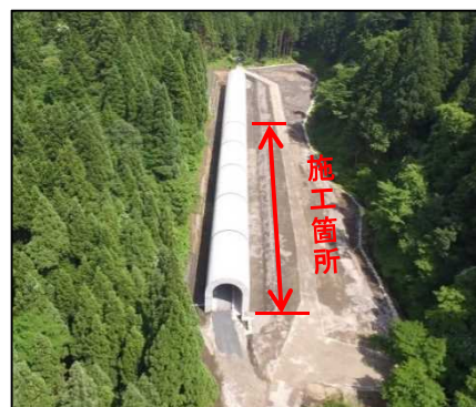
施工箇所写真
