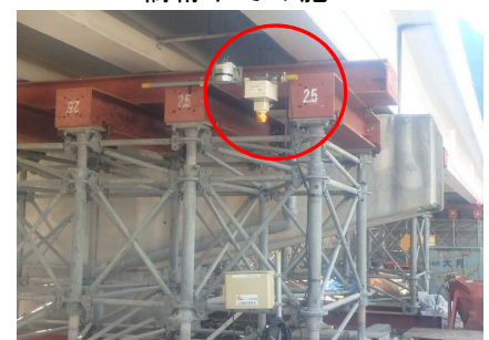
レーザーバリア設置状況
