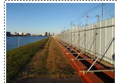
山留材による仮囲い基礎
