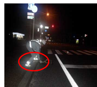
【作業状況(夜間)】
