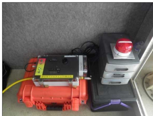
一酸化炭素検出装置設置状況
