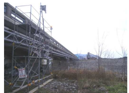
レーザーバリア設置状況
