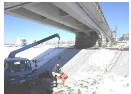
橋下施工状況
