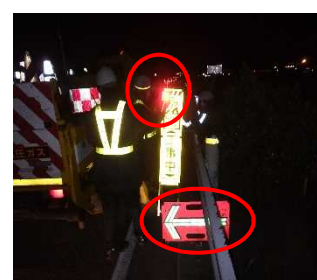
【警告灯(赤色)設置】
