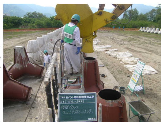
コンクリート打設状況
