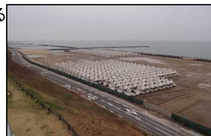
【ブロック製作ヤード全景】
