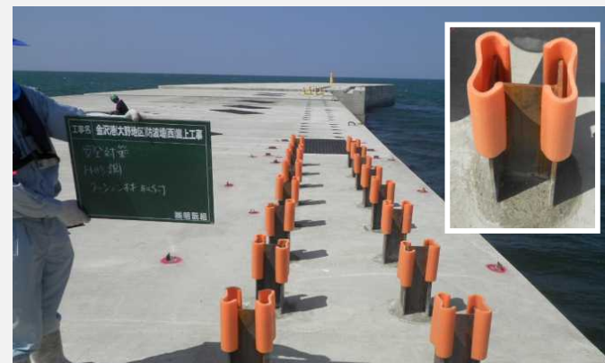
H形鋼設置時にクッション材取付
