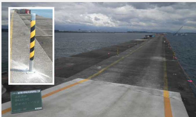
連絡通路の端部・段差部の明示と整備
