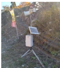
土石流警報装置
