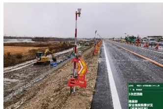
県道迂回路 路肩明示
