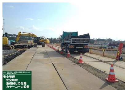
①建設機械と工事車両の分離措置
