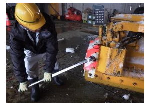
写真④ トルクレンチによる締め付け状況
