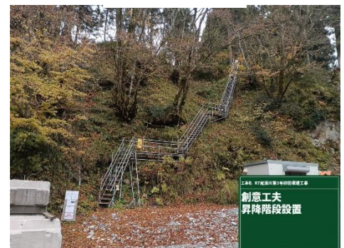
右岸からの避難通路
